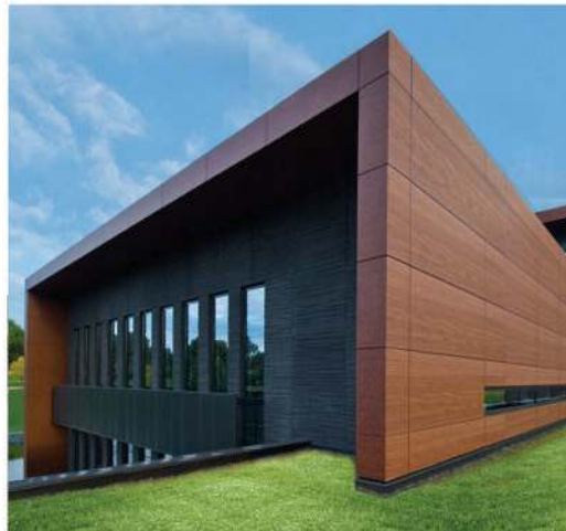
REVESTIMIENTO DE FACHADAS
